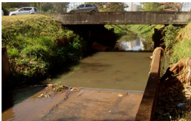
Figura 2: Início da canalização do corpo hídrico
